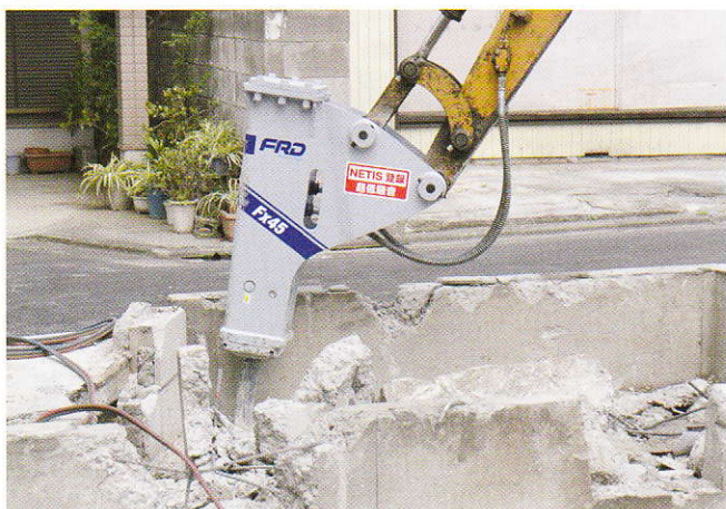
下町の家屋解体現場で活躍するFx45 SS-box
